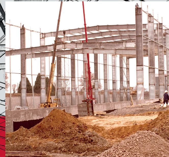
Construction de l'usine Galva Métal à Écouflant
